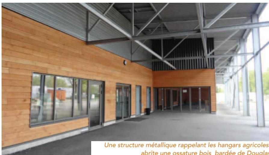
Une structure métallique rappelant les hangars agricoles, abrite une ossature bois bardée de Douglas
