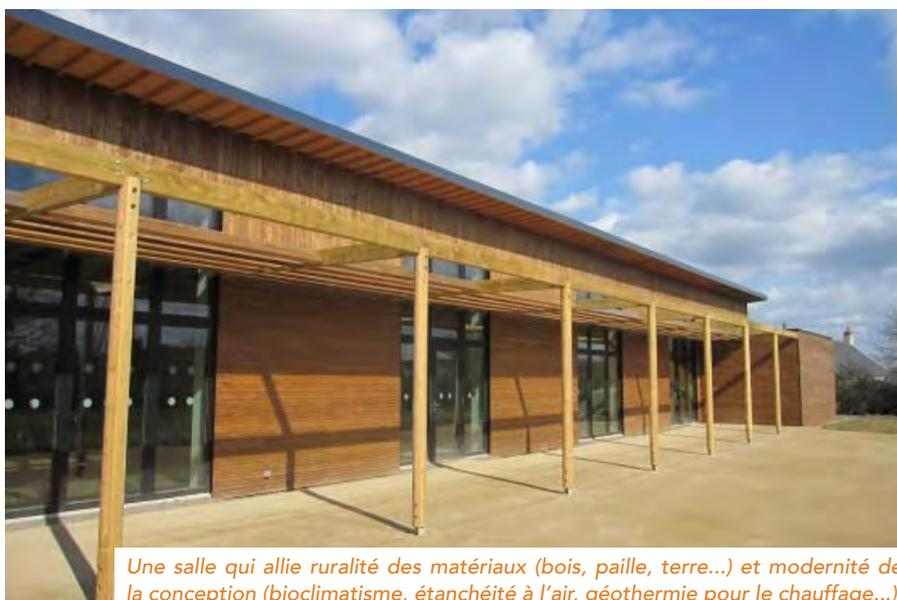
Une salle qui allie ruralité des matériaux (bois, paille, terre...) et modernité de la conception (bioclimatisme, étanchéité à l'air, géothermie pour le chauffage...)
