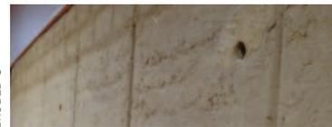
Reprenant une technique utilisée dans les abbayes, des orifices de tailles et formes variables sont créés dans le couloir central, pour capturer des fréquences différentes et améliorer l'acoustique. ■
