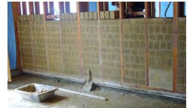
Pendant la phase de conception, quelques kilos de terre ont été extraits du champ où allait être construit le futur groupe scolaire, afin d'en évaluer la qualité en vue de la fabrication de brique de terre comprimée (BTC). Tests positifs : il a donc été décidé de mettre de côté la terre argileuse au moment de faire les fondations.
